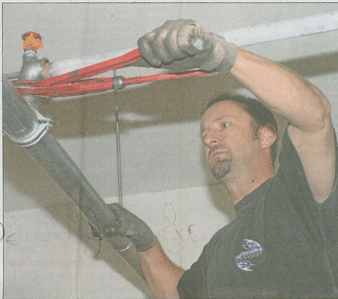
Die vormals roten Rohre werden nach und nach durch doppelt verzinkte silberne glänzende Leitungen ersetzt.
